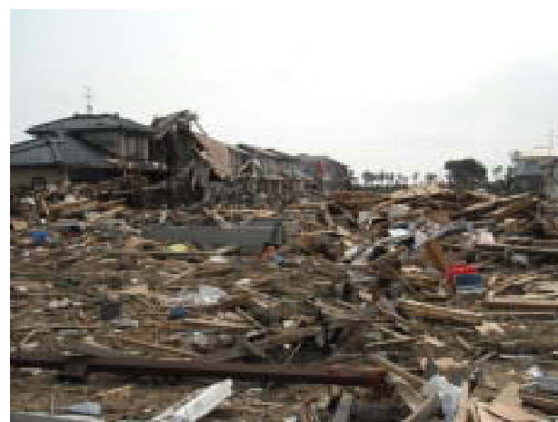
倒壊している家屋(仙台市若林区)
